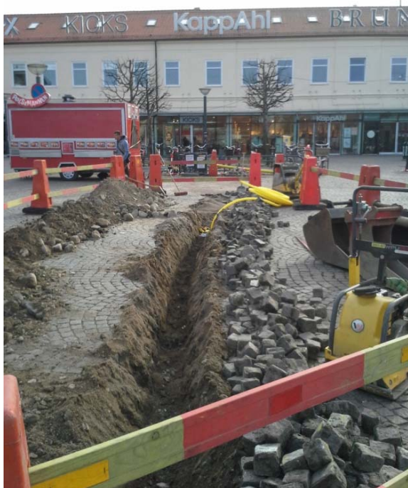
Figur 5. Det sydvästligt till nordöstligt orienterade schaktet, del III, fotografi från väster.
