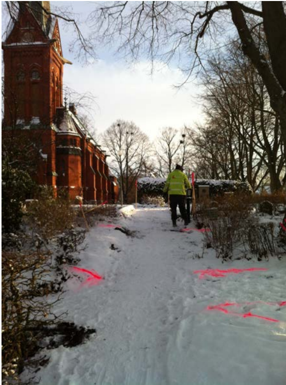
Figur 4. Norra Nöbbelövs kyrka med sträckningen för schaktet i östvästlig riktning. Fotografiet är taget från väster.
