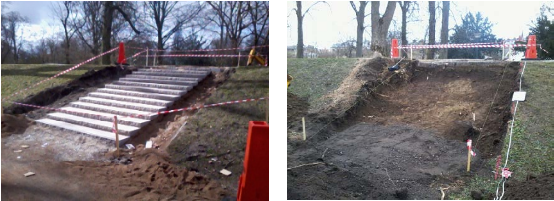
Figur 4. Då Kulturens personal anlände till platsen hade den östra delen av trappan färdigställd medan den västra var schaktad och delvis fylld med bärlager.
